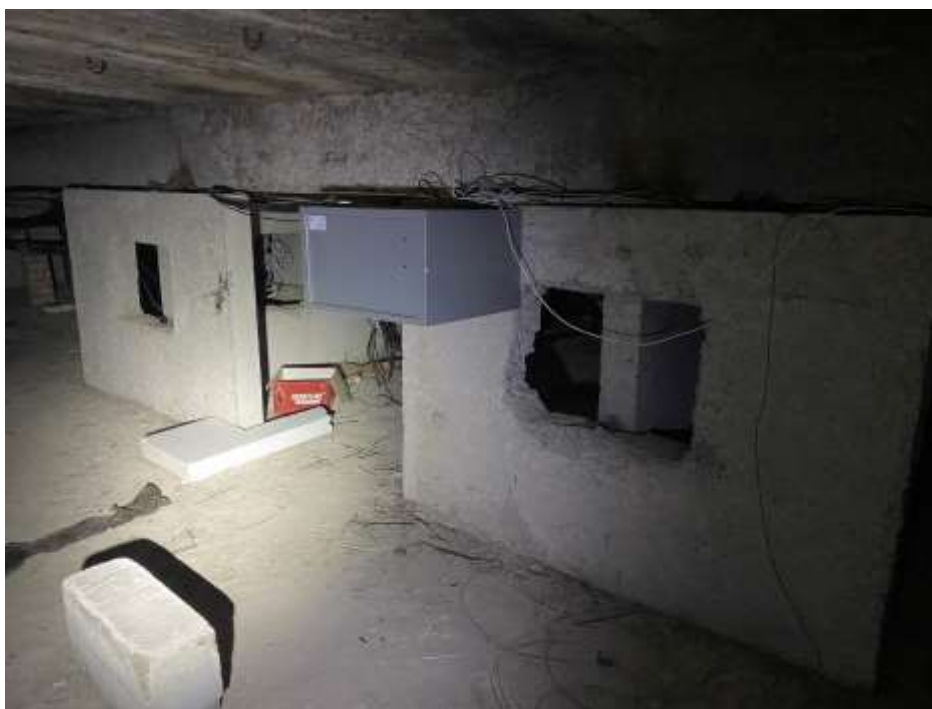
4.8.1.att. Jumta nesošais elements – trapeceveida jumta panelis.
