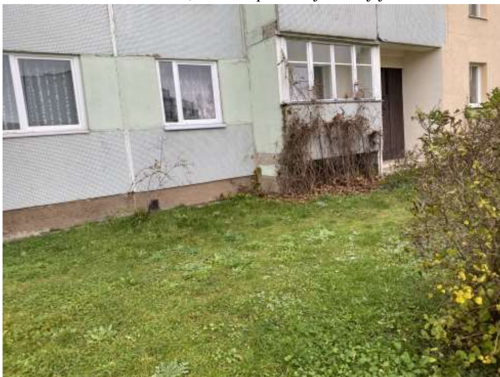
4.2.6.att. Sala, mitruma piesātinājuma bojājumi uz sienām, vītenaugs pie lodžijas
