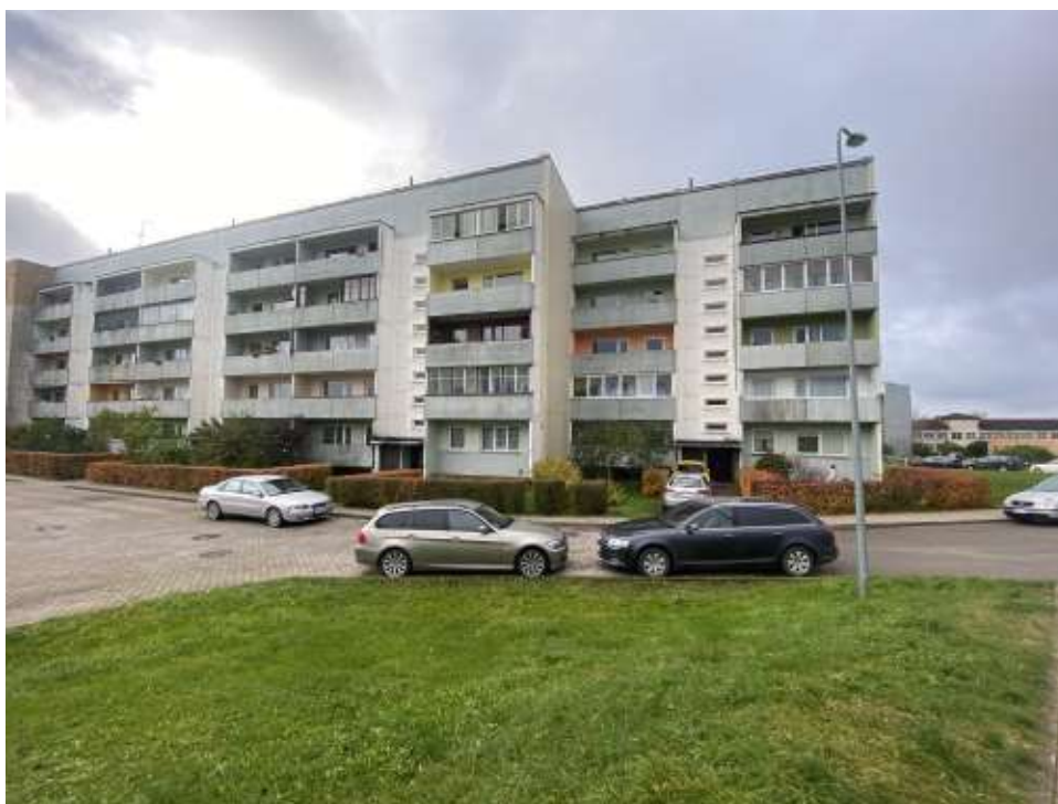
4.9.1.att. Lodžiju konstrukcijas
