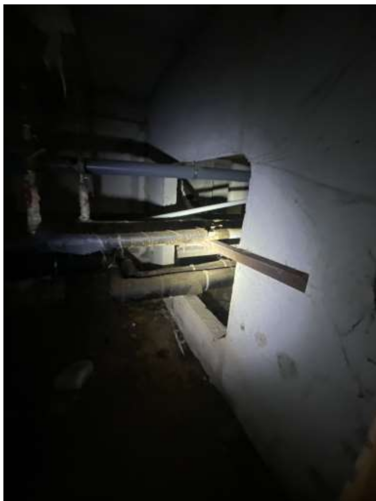
4.1.4. att. Saliekamā dzelzsbetona sienu konstrukcijas
