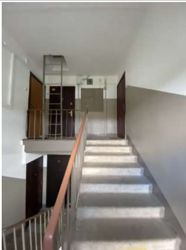
4.2.7.att. Kāpņu telpas sienās netika konstatētas plaisas vai mitruma bojājumi
