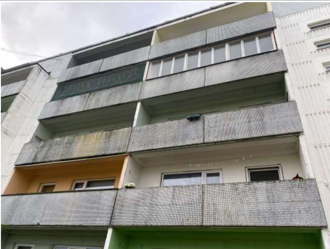
4.9.6.att. Lodžiju konstrukcijas
