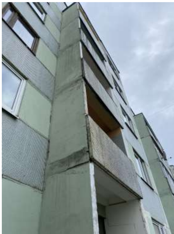
4.9.5.att. Lodžiju konstrukcijas
