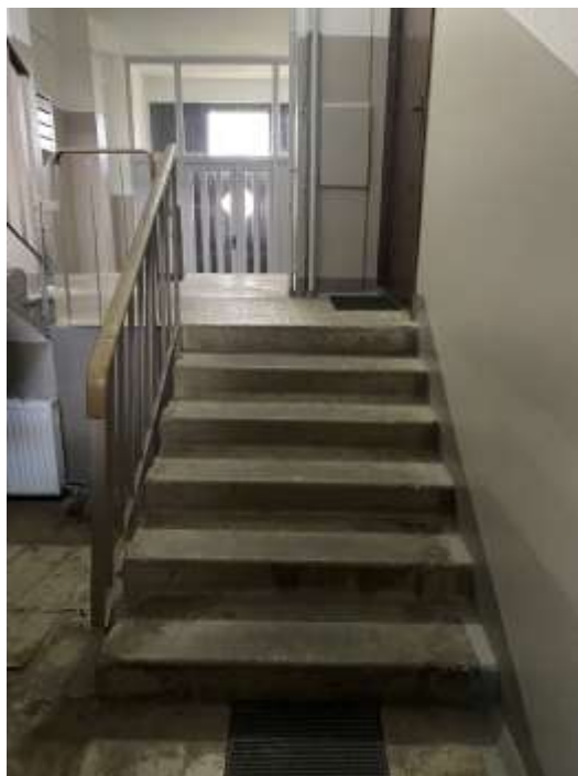
4.10.3.att. Dzelzsbetona konstrukciju starpstāvu kāpnes
