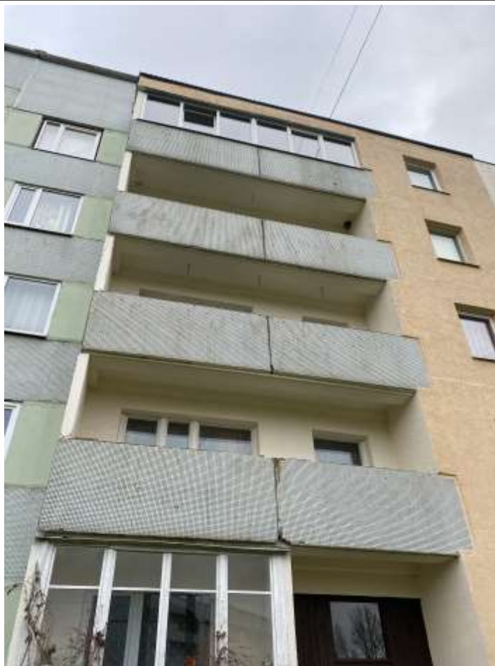
4.9.4.att. Lodžiju konstrukcijas
