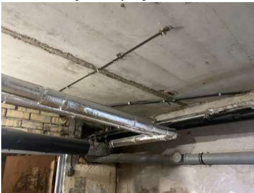
4.6.2.att. Pagraba stāva pārsegums
