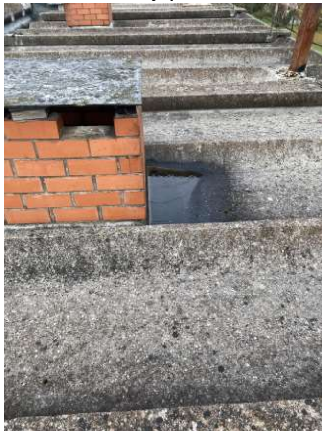
4.8.7.att. Mitruma un sala ietekmē bojāti jumta klāja elementi, lietus ūdens nespēj aizecēt
