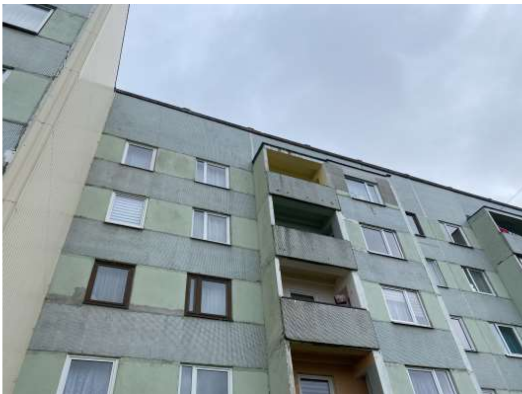
4.9.3.att. Lodžiju konstrukcijas
