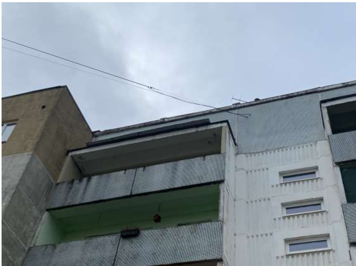
4.9.7.att. Lodžiju juma konstrukcija nepieciešams atjaunot jumta segumu
