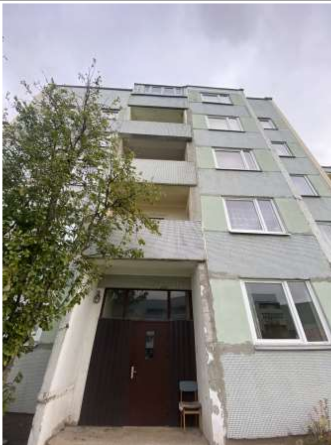
4.9.2.att. Lodžiju konstrukcijas
