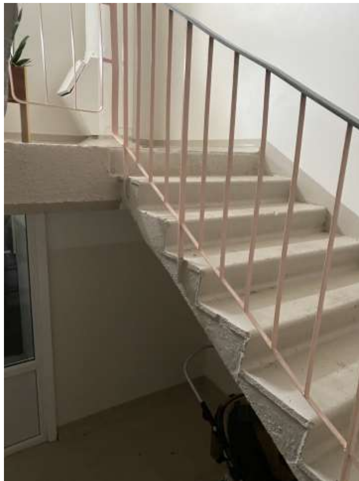
4.10.1.att. Dzelzsbetona konstrukciju starpstāvu kāpnes
