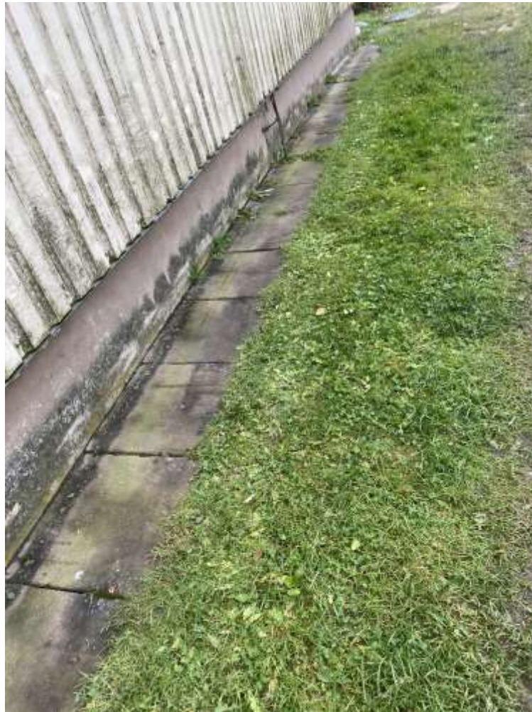
4.1.4. att. Ēkas pamatu apmales
