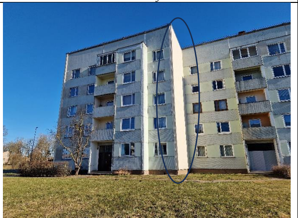
3.att. Ēkas D un Z fasādes daļas ir siltinātas
