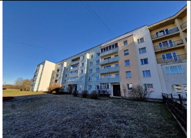
2.att. Ēkas R fasāde.
