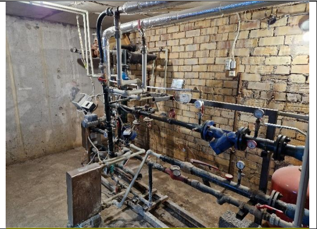
5. Ēkā uzstādīts neatkarīgā pieslēguma tipa siltummezgli, kurā tiek padots ēkas apkures loka siltumnesējs, kā arī tiek sagatavots karstais ūdens. Apkures un karstā ūdens siltummaiņus nepieciešams aprīkot ar siltumizolācijas apvalkiem
