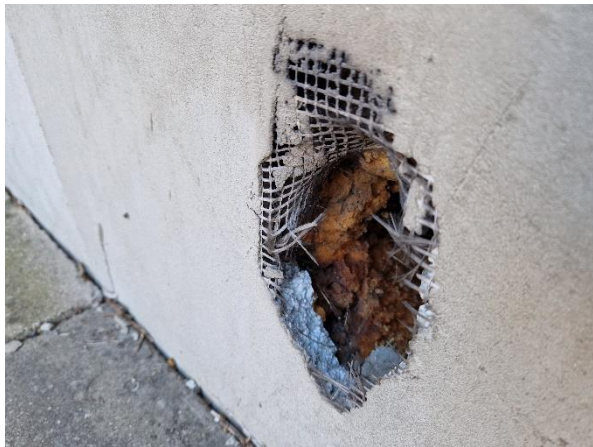
4.att. Neliela daļa no ēkas fasādes jau ir siltināta ar 100mm izolācijas slāni. Atbilstoši sniegtajai informācijai, siltināšanas darbi veikti kvalitatīvi, taču atsevišķos apgabalos nepieciešams veikt apkopes darbus, lai nodrošinātu siltinājuma slāņa ilgtspēju
