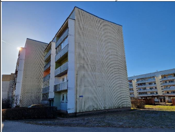
3.att. Ēkas D un Z fasādes daļas ir siltinātas
