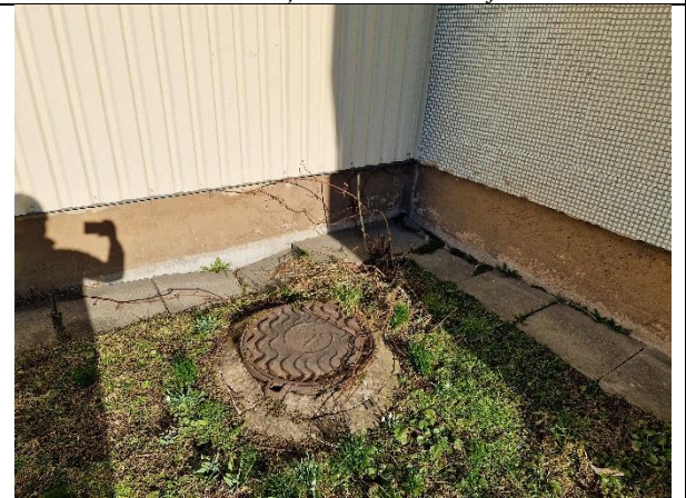
9.att. Nepieciešams sakārtot pamatu apmali, lai nodrošinātu efektīvu lietus ūdens novadīšanu
