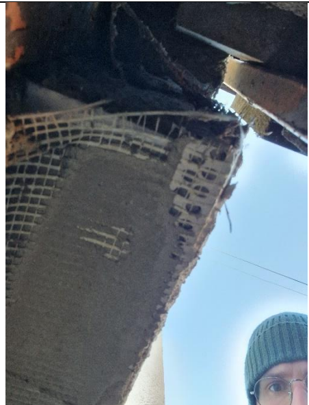
4.att. Neliela daļa no ēkas fasādes jau ir siltināta ar 100mm izolācijas slāni. Atbilstoši sniegtajai informācijai, siltināšanas darbi veikti kvalitatīvi, taču atsevišķos apgabalos nepieciešams veikt apkopes darbus, lai nodrošinātu siltinājuma slāņa ilgtspēju
