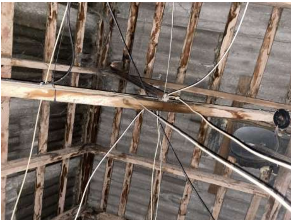
4.8.4.att. Jumta konstrukcijas
