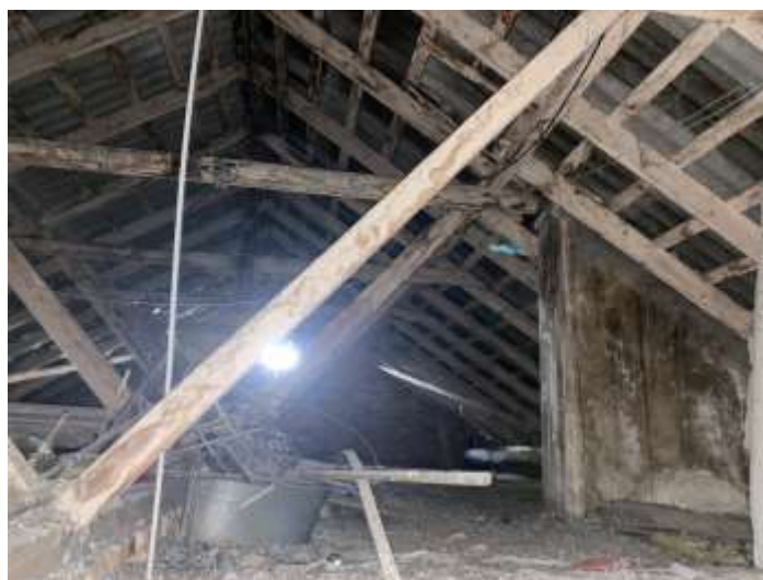
4.8.1.att. Jumta konstrukcijas
