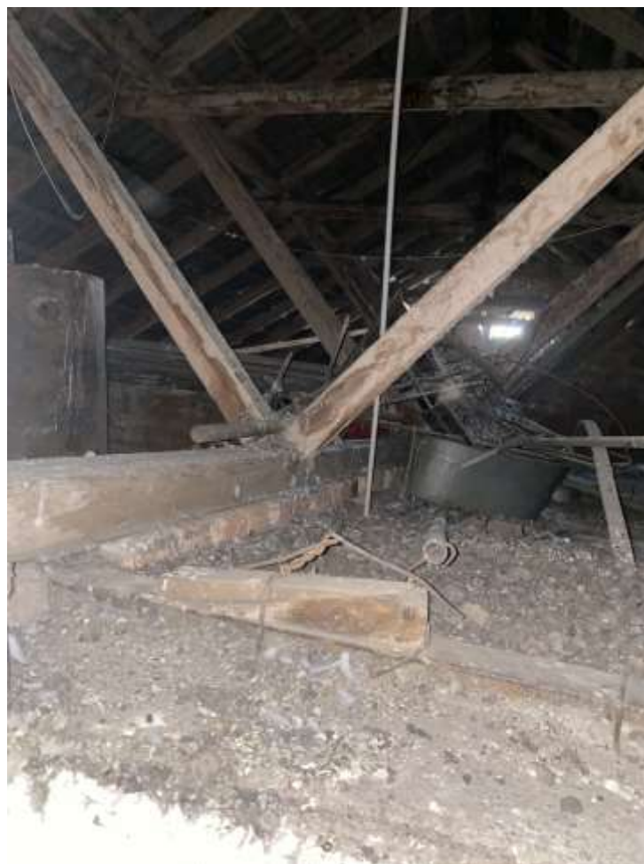
4.8.5.att. Jumta konstrukcijas
