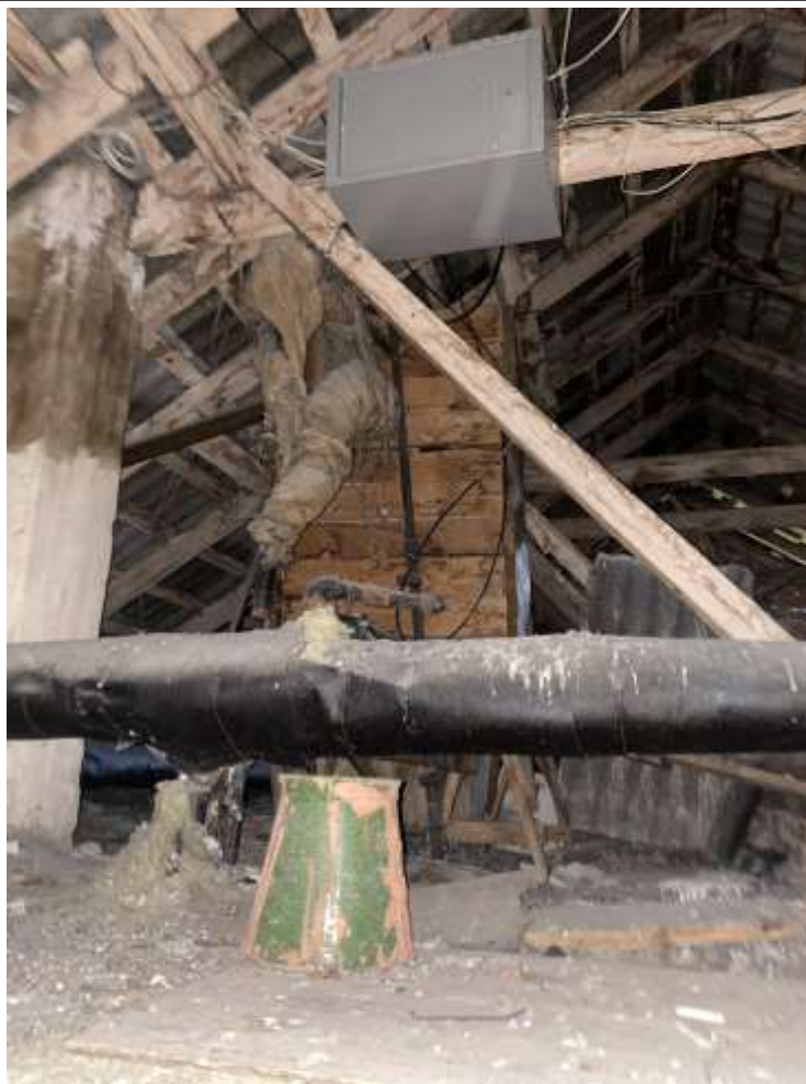
4.8.2.att. Jumta konstrukcijas
