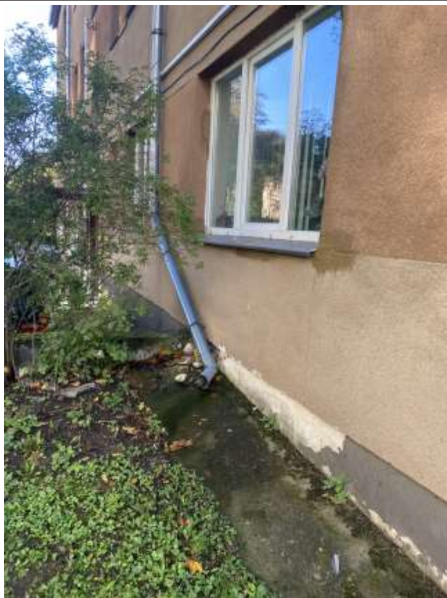
4.1.3. att. Ēkas pamatu apmales
