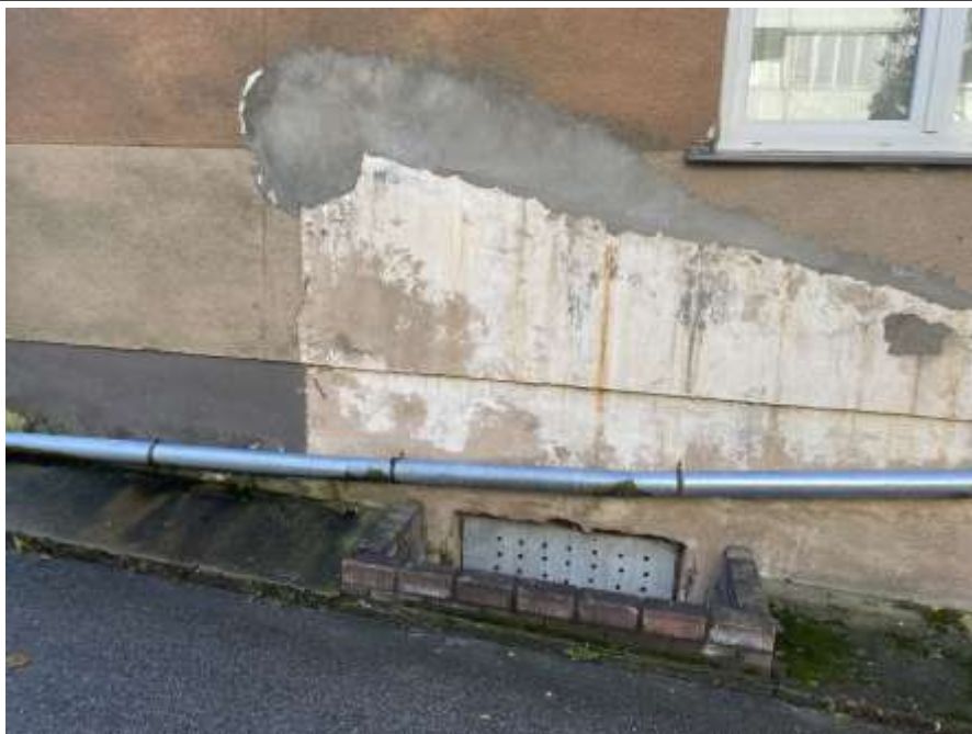
4.2.1.att. Sala, mitruma piesātinājuma bojājumi no lietus ūdens novadīšanas sistēmas
