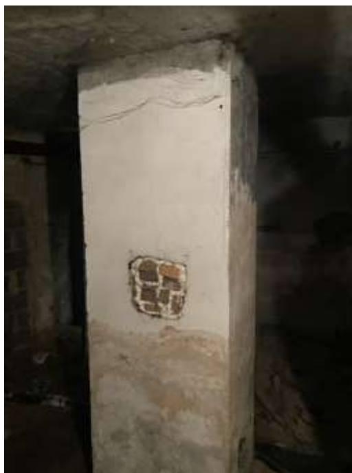
4.3.1.att. Pagraba kolonnas konstrukcija
