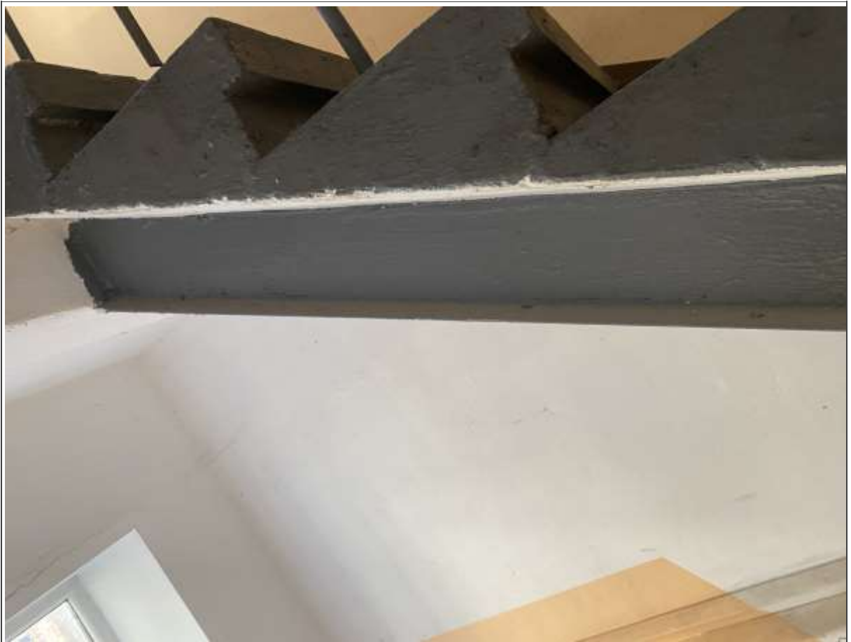
4.10.2.att. Dzelzsbetona konstrukciju kāpnes
