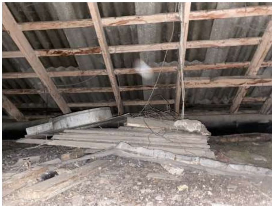
4.8.3.att. Jumta konstrukcijas
