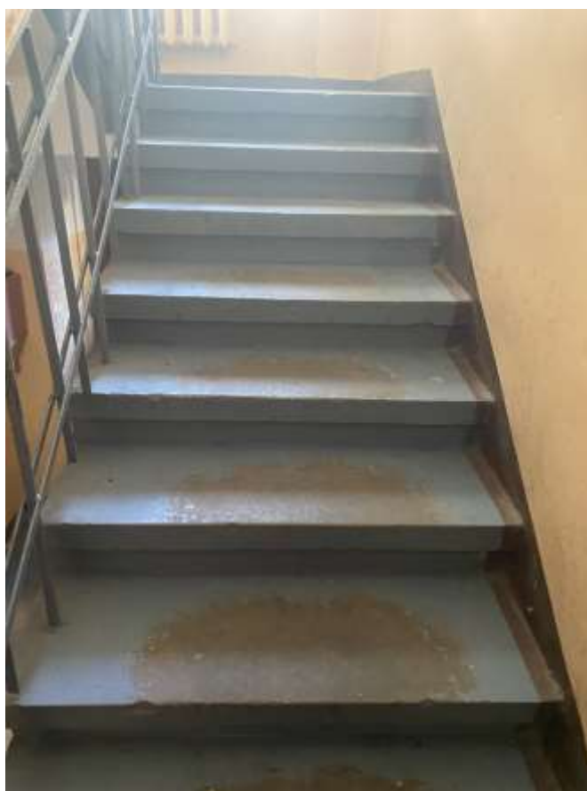
4.10.1.att. Dzelzsbetona konstrukciju starpstāvu kāpnes
